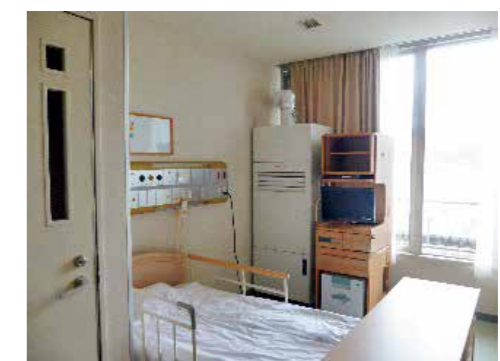
(写真3)病室内 中央にある白い装置が陰圧装置
